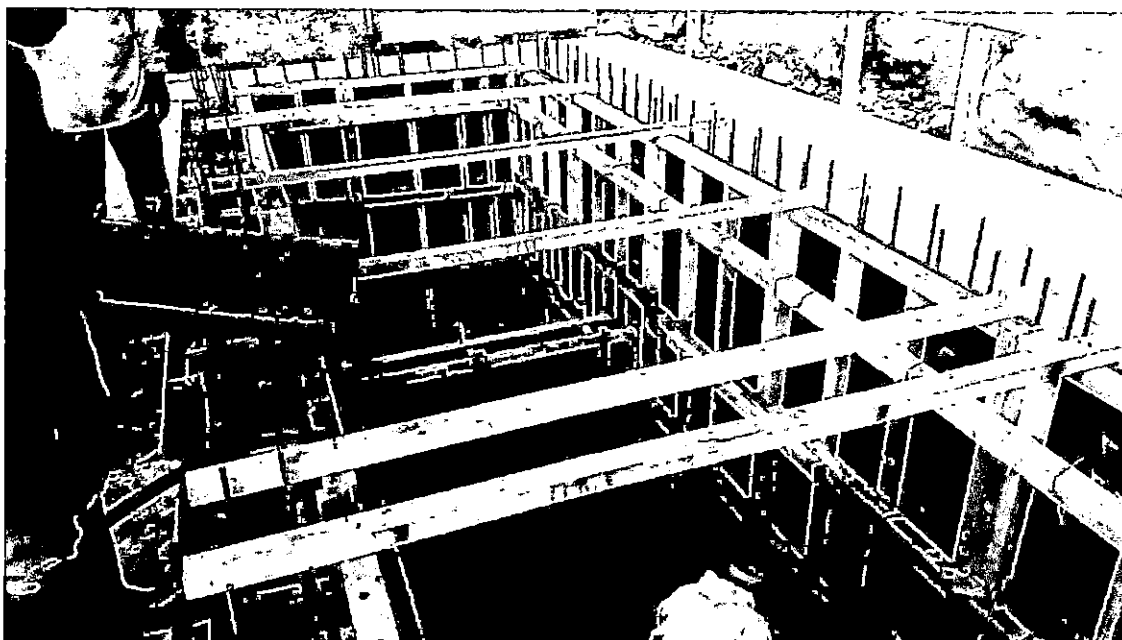
VACIADO DE CIMENTO DE CISTERNA
