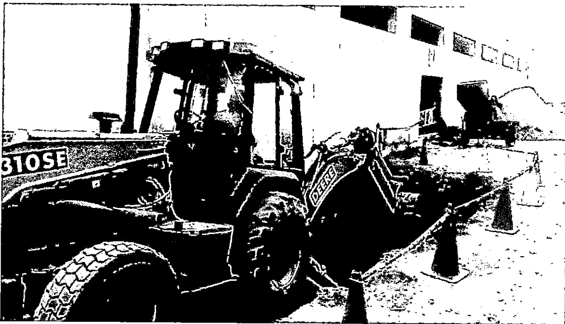
EXCAVACION PARA LA CISTERNA DEL AREA DE FRIO
