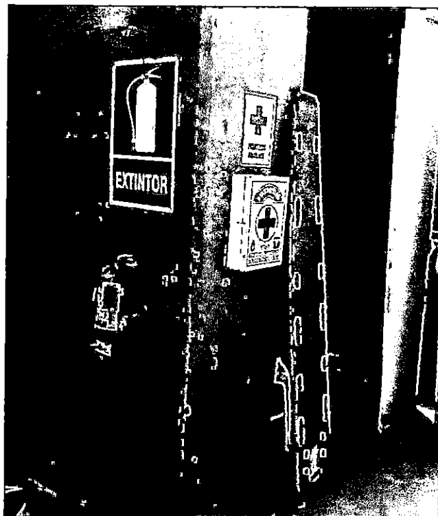
EXTINTOR EN OBRA
